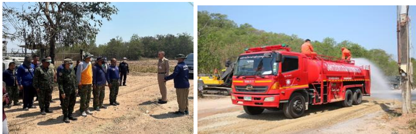
ภาพที่ ๓- ๔ ผบ.รฐท.สส. ตรวจสอบพื้นที่การปักเสา พาดสายไฟฟ้า และปรับปรุงถนนรวมทั้งปัญหาขยะชุมชนในหมู่บ้านมั่นคง ชุมชนพลุดาหลวง
