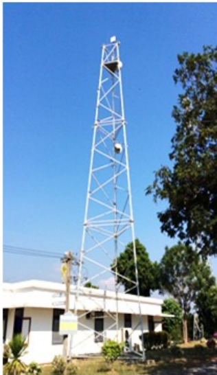
แบบ THREE LEGS SELF SUPPORT ความสูง 18 เมตร
