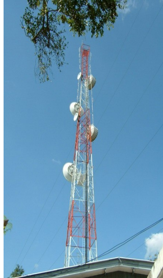
แบบ FOUR LEGS SELF SUPPORT ความสูง 80 เมตร
