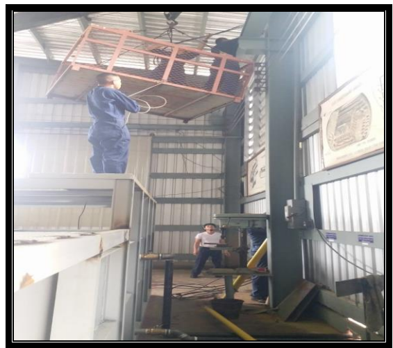
ติดตั้งตู้ควบคุมพร้อมเดินสาย
