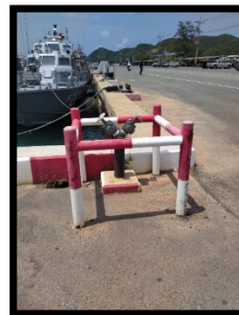
รูปภาพ : ระบบน้ำดับเพลิงพื้นที่ ท่าเทียบเรือแหลมเทียน
